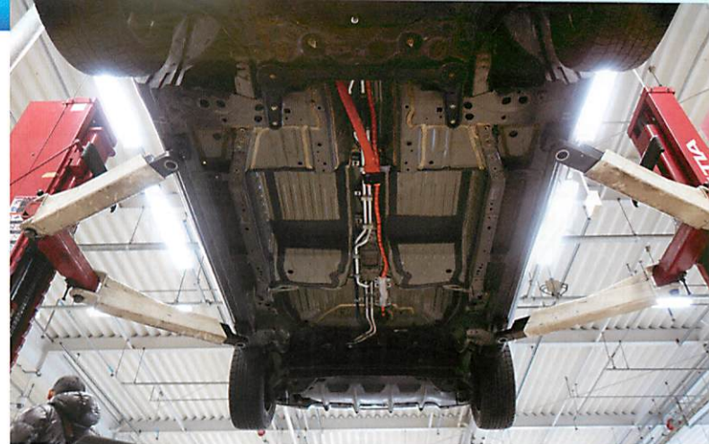
交換のため、バッテリーが取り外されたアンダーフロア。バッテ リーの重量は補器類を含めると300kg以上。日産でも指定され た工場でのみ交換作業ができる。
